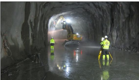
Felsreinigung bei Unterprofil im Løvstakktunnel
