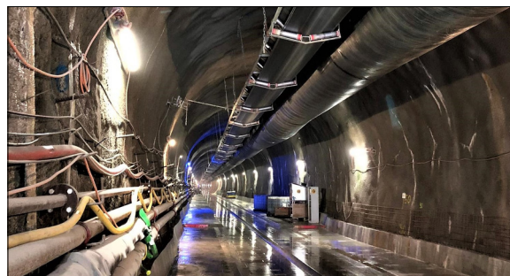
Blick in den Tunnel Eigene Darstellung
