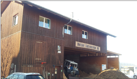
Zentrale der Heider Holzenergie AG in Tagelswangen ZH
