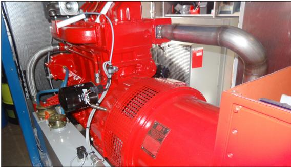
Betrachtetes BHKW ohne Verkleidung, links im Bild Synchrongenerator, rechts im Bild Gasmotor
