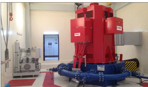
Vertikalachsiges Peltonrad (ANDRITZ Hydro)
