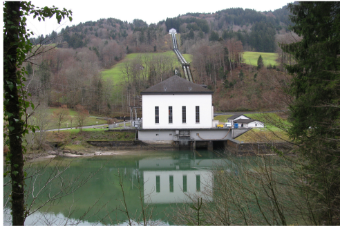
Betriebsgebäude der Zentrale Rempen
