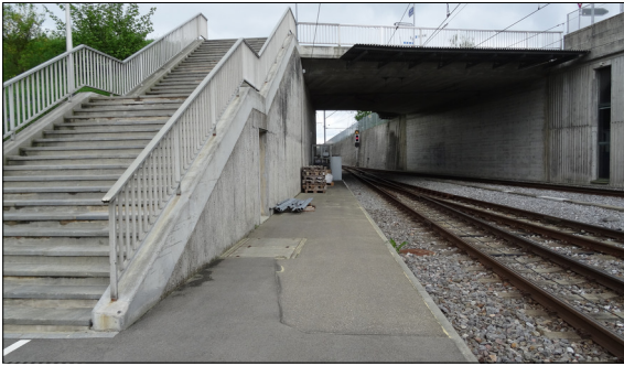
Strassenbrücke über der Forchbahn mit Treppenaufgang
