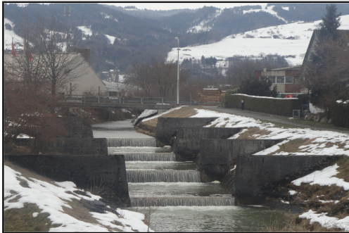
Hochwassersperren im Spreitenbach
