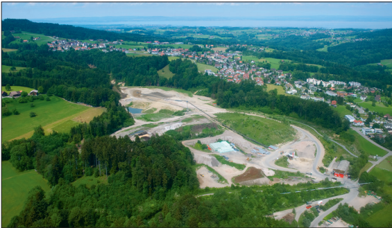
Deponie Tüfentobel, nordwestlich von St. Gallen
