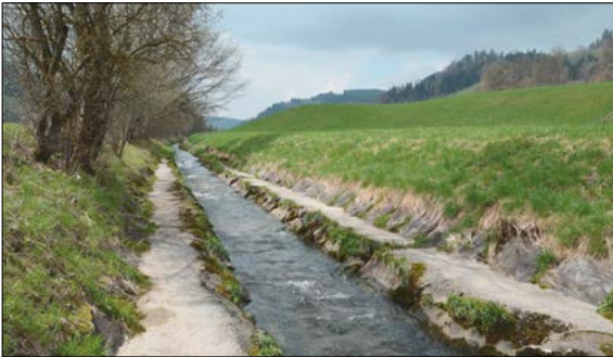
Bestehender Zustand: das zum Transportgerinne degradierte Gewässer
