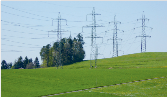
Höchstspannungsleitungen sind landschaftlich markant wirkende Elemente
