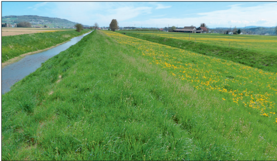
Heutige Situation mit dem kanalisierten Chemenbach und dem zukünftigen Hochwasserrückhaltebecken
