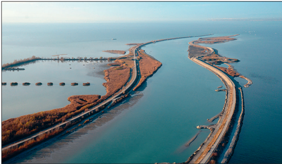
Rheinvorstreckung im Bodensee: ein reines Hochwasserprojekt von einmaliger Dimension
