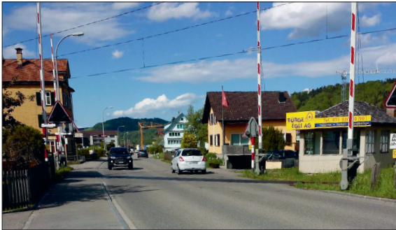
Bestehender Strassenraum beim Bahnübergang
