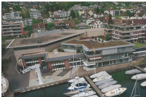
Luftansicht der Werft
