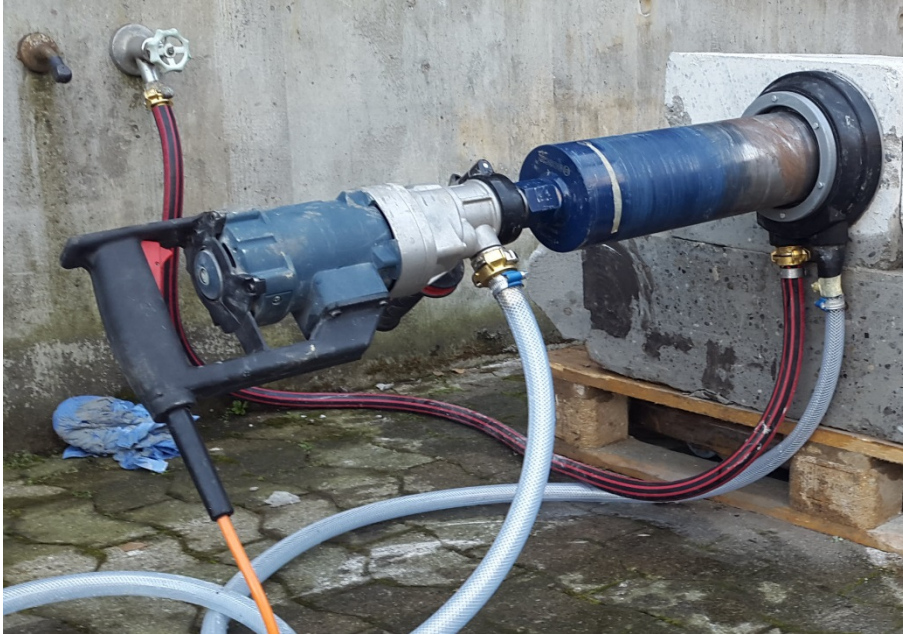
Horizontalbohren in armierten Betonblock
