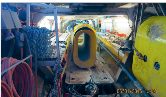
Beispiel-Problem Logistik: Enge Platzverhältnisse im Bereich NL 8, 06,01,15, Bild SiSto Sachseln
