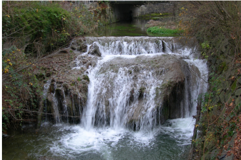
Nicht fischgängiges Absturzbauwerk am Ellikerbach bei Ellikon
