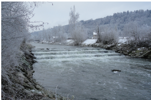
Potentieller Standort einer Kleinwasserkraftanlage an der Glatt bei Glattfelden
