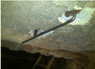
Absaugstutzen im Feuerraum
