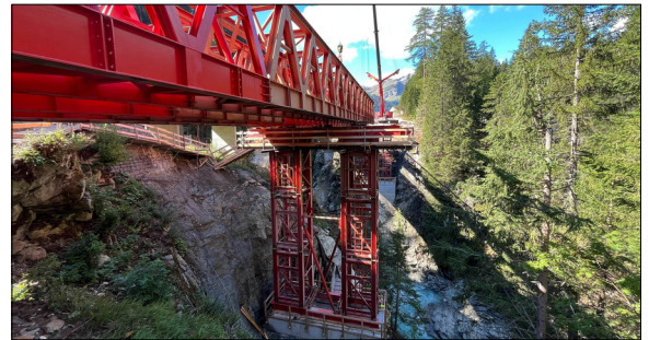
Lehrgerüst als Durchlaufträger, flachfundiert auf Fels Eigene Darstellung
