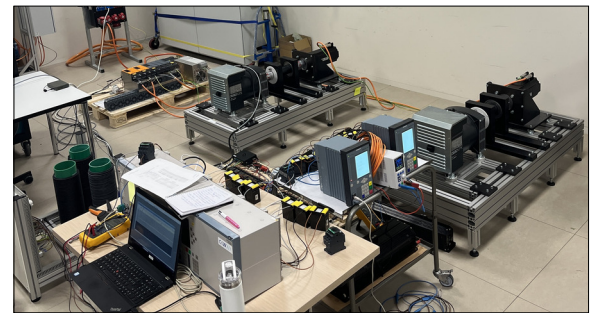
Im Hintergrund zwei Generatorgruppen mit je 8 kVA Leistung und vorne SIPROTEC Schutzgeräte Eigene Darstellung
