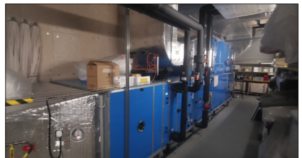
Ausschnitt Wärmeverteilung FH Rapperswil. (Pumpen, Ventile oben und unten und manuelle Temp. ablesen möglich) Eigene Darstellung
