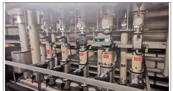
Ausschnitt Wärmeverteilung FH Rapperswil. (Pumpen, Ventile oben und unten und manuelle Temp. ablesen möglich) Eigene Darstellung
