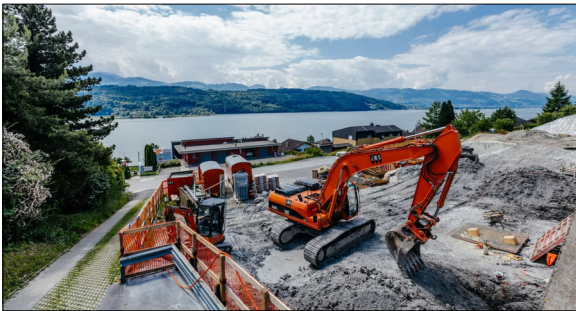
Bagger der JMS-Flotte jms.ch
