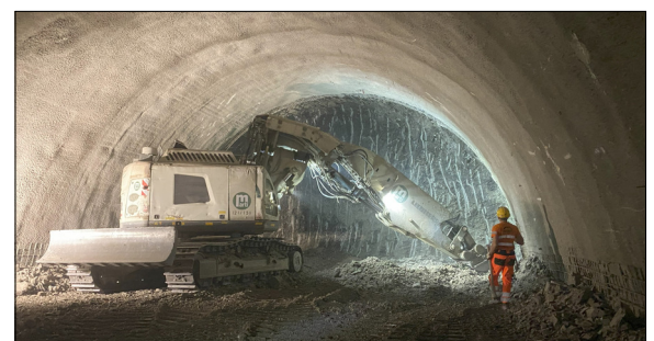
Felsreinigung der Ortbrust Eigene Darstellung
