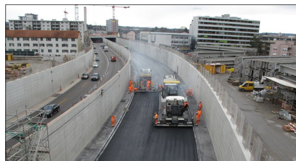
Belagseinbau bei der Einhausung Schwamendingen Eigene Aufnahme
