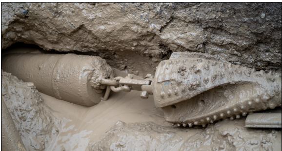
Rohreinzug Wasserleitung Fährnlibrunnenstrasse Projektunterlagen: Basler & Hofmann AG
