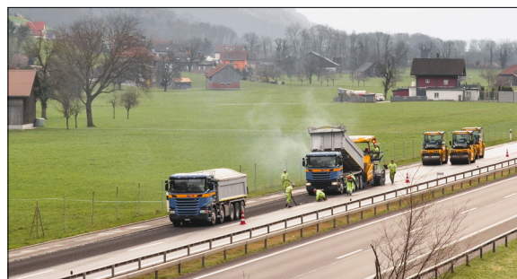
Einbau des neuen SDA-Deckbelages Eigene Darstellung
