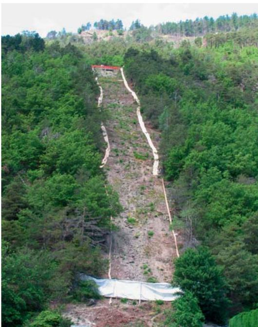
Abb. 11 Steilhang mit Längsanoden.
