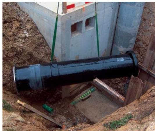
Abb. 14 Isolierkupplung mit integrierter Isolier- und Ringfunkenstrecke.
