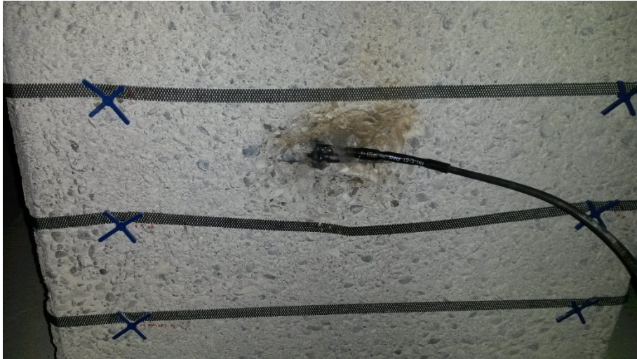
Bild 4: Aktivierte Titanbänder auf Stützensockel mit Bewehrungsanschluss
