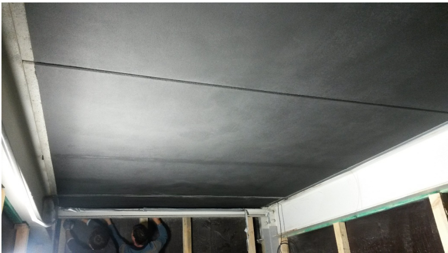
Bild 7: Leitfähige Beschichtung (schwarzer Anstrich auf Betonoberfläche mit Anschlüssen)
