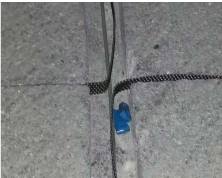
Bild 5: Aktiviertes Titanband in Betonschlitz eingelegt
