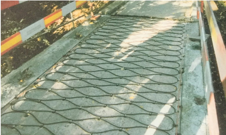
Bild 2: Elektrisch leitende Polymeranoden (Quelle: Raychem)
